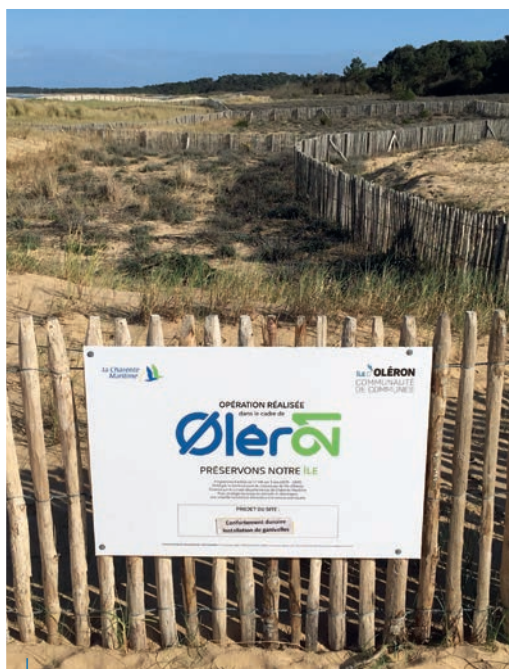
Confortement dunaire sur le site de Plaisance
