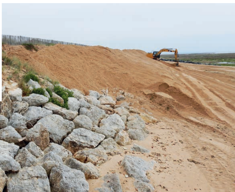
Travaux de réensablement sur le site des Placelles
