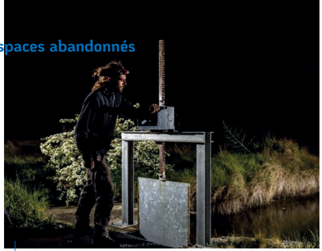
Manipulation d'écluse au marais du Douhet pour gérer le niveau d'eau des chenaux
