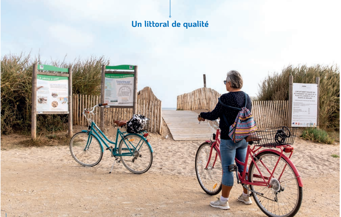
Installation de caillebotis et d'une signalétique sur la Pointe de Prouard
