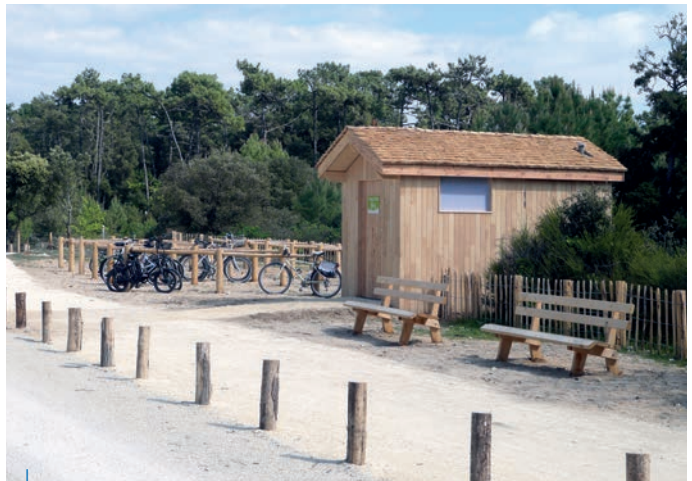
Réhabilitation globale du site des Saumonards (toilettes sèches, voirie, stationnements vélos et voitures...)
